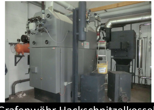
Grafenwöhr Hackschnitzelkessel
